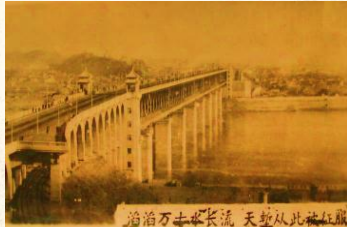
武汉长江大桥
